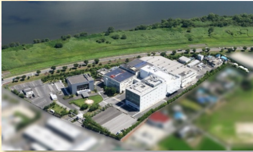
千葉工場全景
